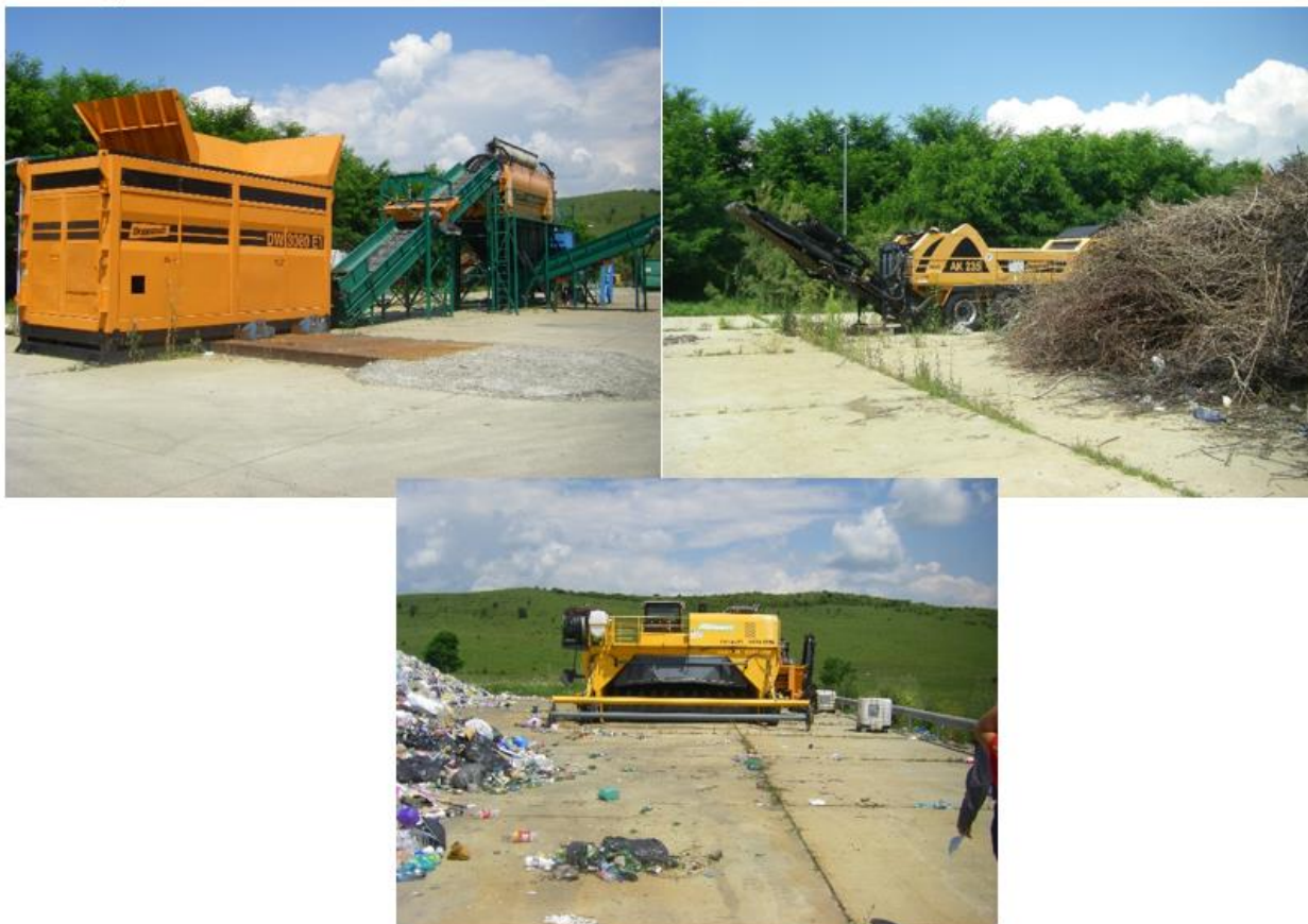
Figura 2-25 Stația de compostare a deșeurilor biodegradabile în cadrul CMID Tărpiu
