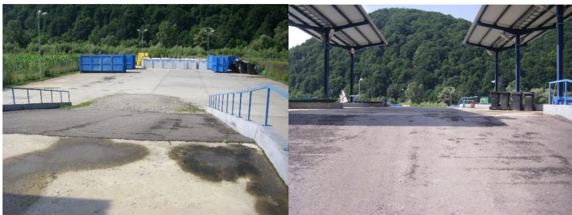
Figură 2-7 Stația de transfer și Centrul de colectare Năsăud
