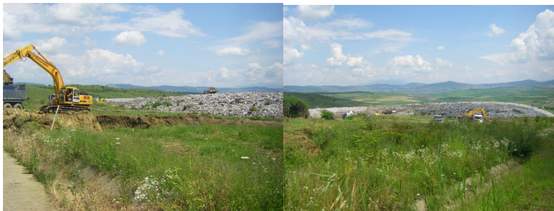
Figura 2-26 Depozitul conform de deșeuri din cadrul CMID Târpiu
