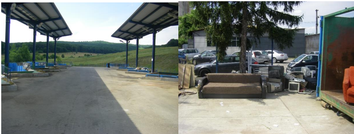
Figură 2-10 Stația de transfer și Centrul de colectare
